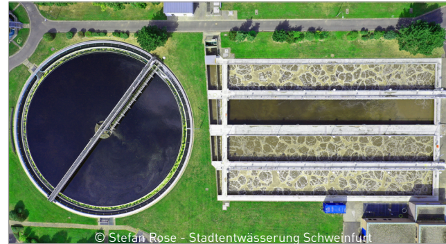
© Stefan Rose - Stadtentwässerung Schweinfurt
